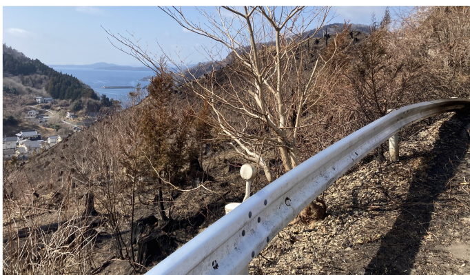
右手：熱で曲がったガードレール 左手：広範囲に消失した森林
